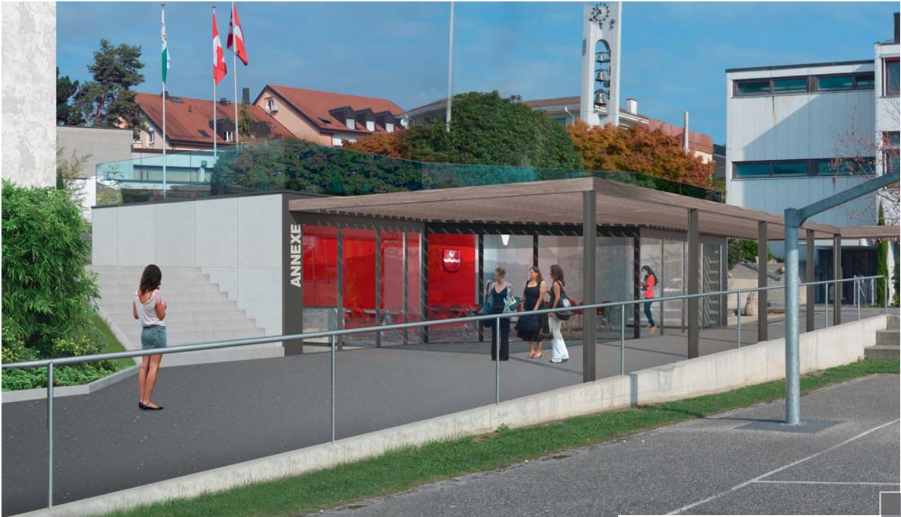
Paudex, rénovation du complexe scolaire et administratif, réalisation d'une annexe polyvalente.
